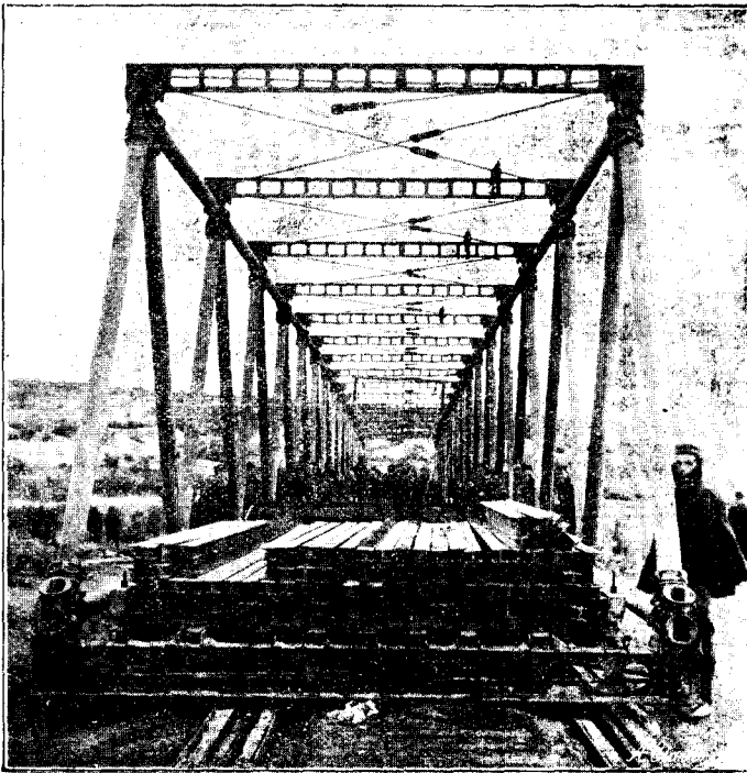
Fig. 5.—Vista de frente del puente.
