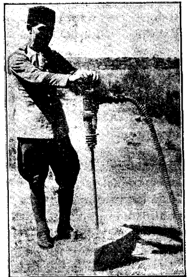
Fig. 8.—Martillo neumático en posición de trabajo.
