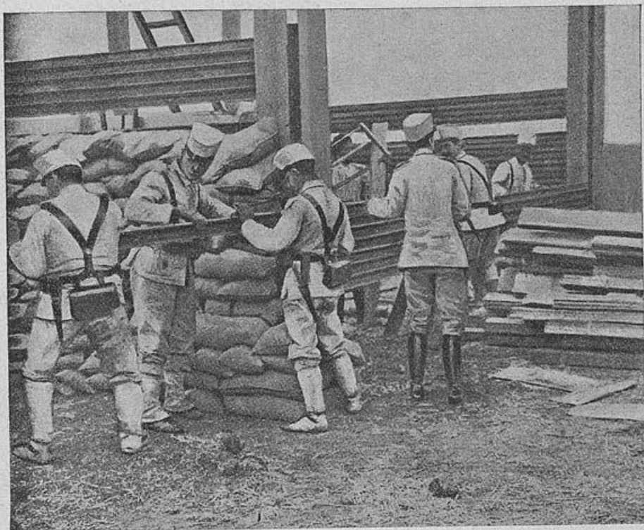
El segundo blocao en construcción entre la segunda caseta y el blocao Velarde
