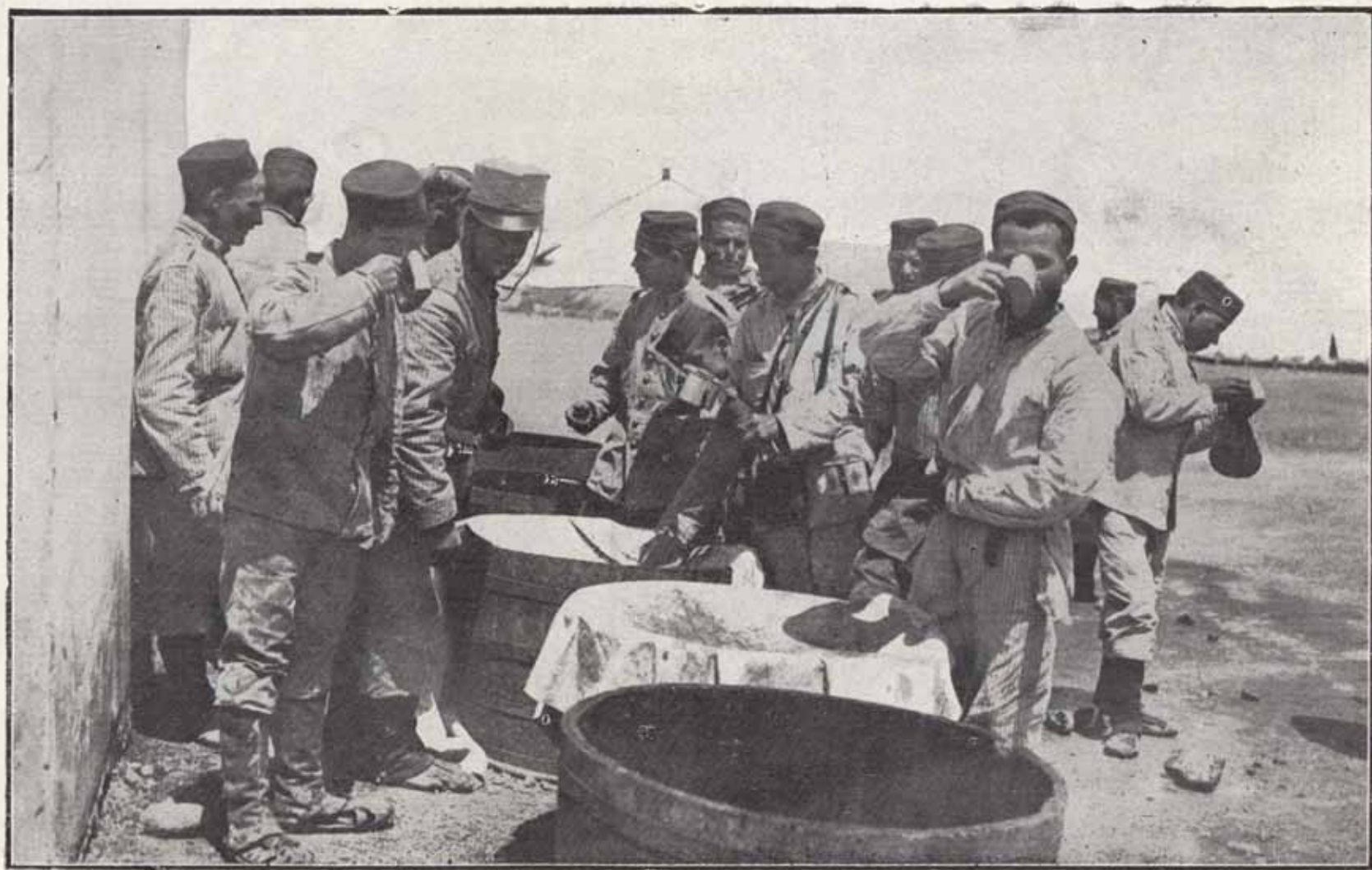
LOS DEPÓSITOS PROVISIONALES DE AGUA EN EL CAMPAMENTO DEL HIPÓDROMO
