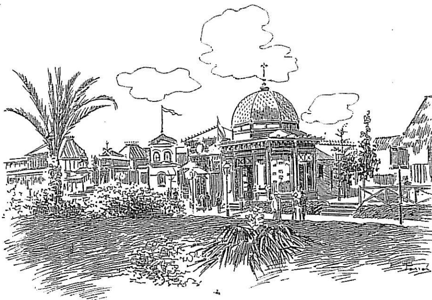
EXPOSICIÓN UNIVERSAL DE BARCELONA Instalaciones al aire libre.
